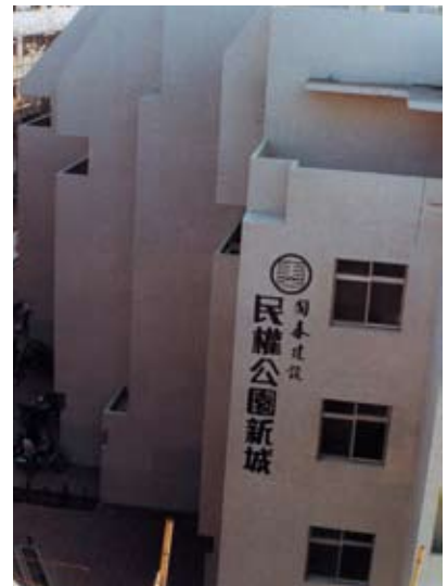
台中分公司第一個工地民權公園新城(67.11)
