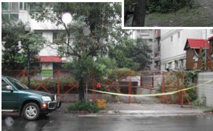
更新前1F車道入口
