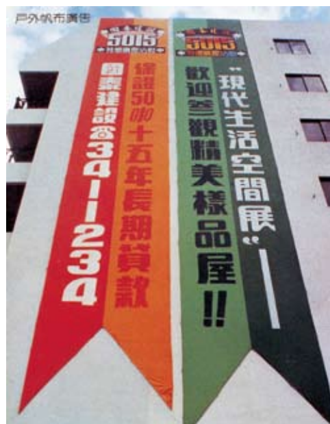
現代生活空間展工地現場
